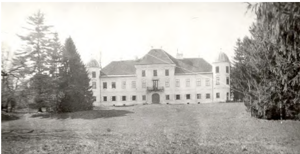
Slika 5. Pogled na ulazno pročelje 1912. godine
