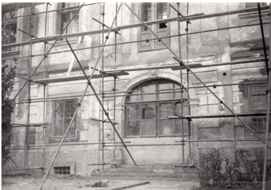
Slika 13. Središnji dio sjevernog pročelja tijekom obnove 1961. godine
