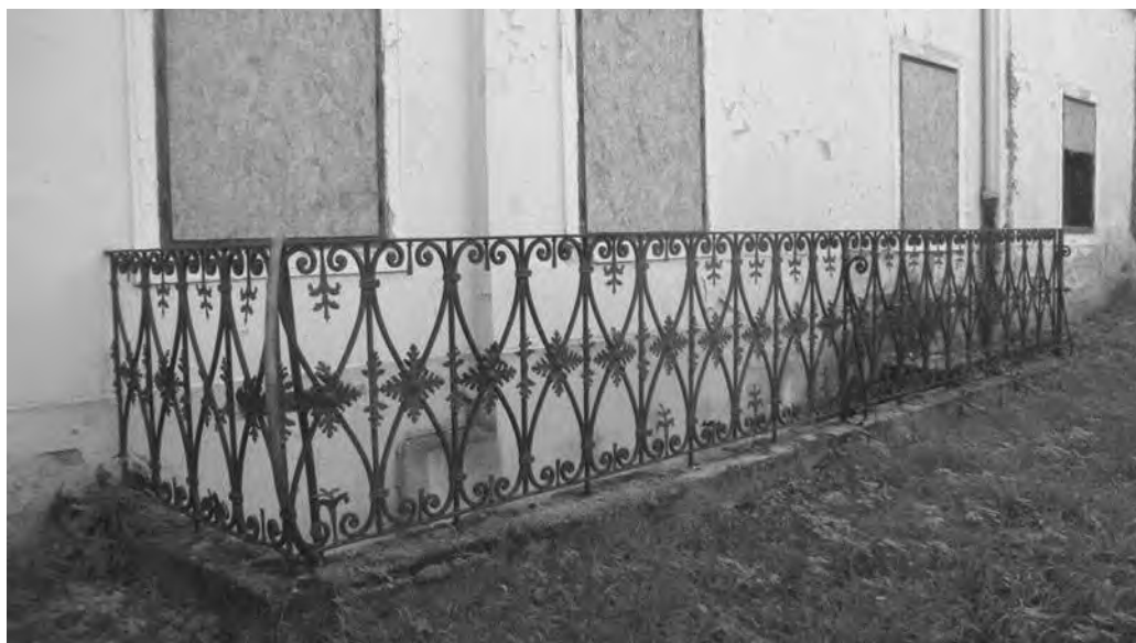
Slika 15. Ograda iznad ulaza u podrum, zapadno pročelje, 2013. godine
