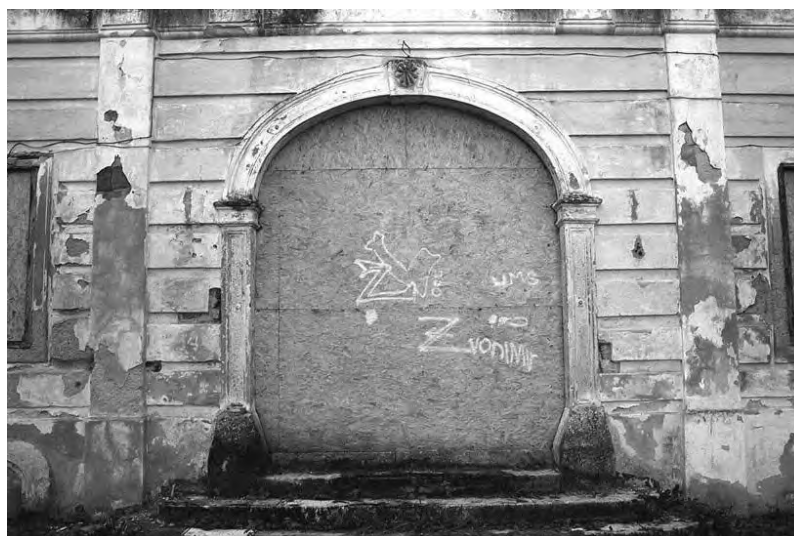
Slika 18. Portal sjevernog pročelja, današnje stanje, 2013.godine
