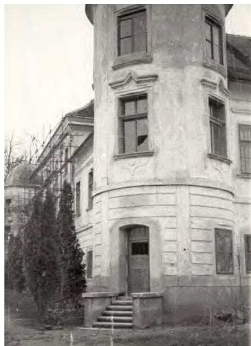
Slika 11. Sjeverno pročelje u tijeku obnove 1961. godine, zapadna kula
