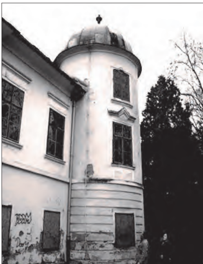
Slika 12. Vanjski pogled na istočnu kulu
