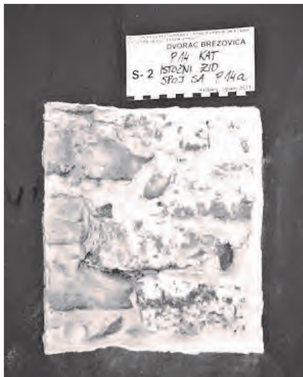
Slika 15. Sonda na spoju glavnoga krila i istočne ugaone kule (S-2 P14/14a KAT)
