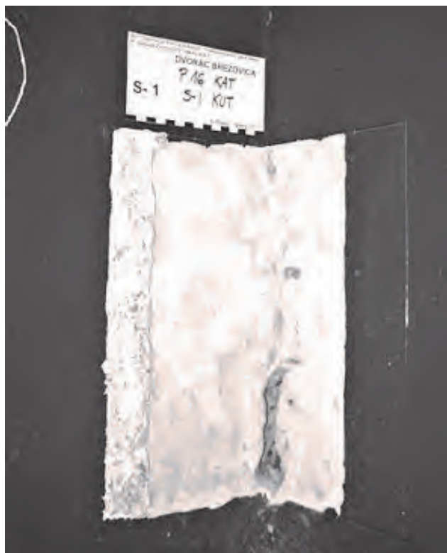
Slika 14. Sonda na spoju glavnoga i istočnoga krila (S-1 P16 KAT)
