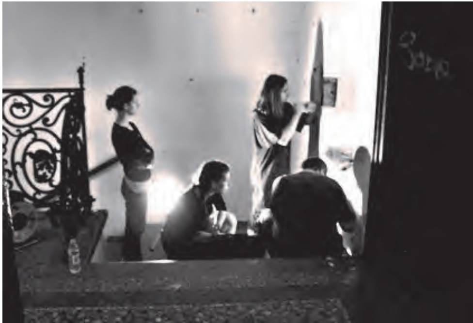
Slika 16. Otvaranje sonde u niši na istočnome stubištu (S-3 P18 KAT)
