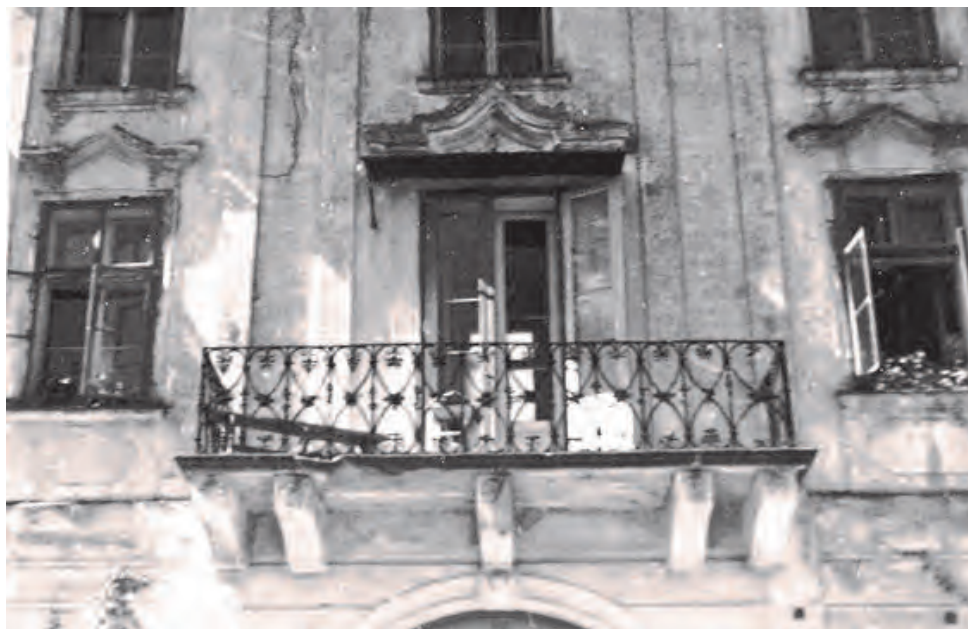
Slika 21. Fotografija balkona koji se nalazio iznad portala na glavnome pročelju
